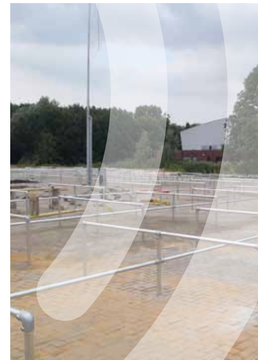
Stalling met aanleunrekken
